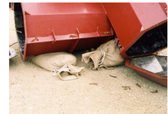
土嚢による安定確保
