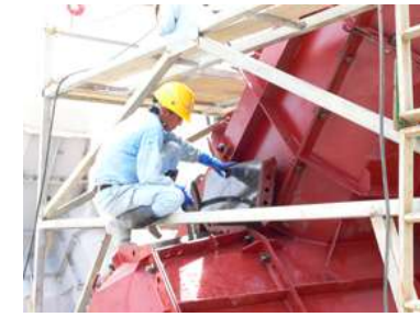
袖部コテ均し
