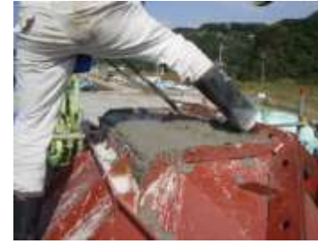
打設口部スペーシング
