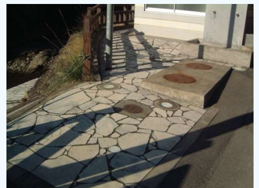
野島川河川プール外構工事 (宮崎県宮崎市内海町 野島川)
