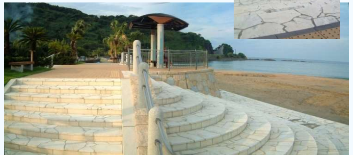
平成14,15年度施工
