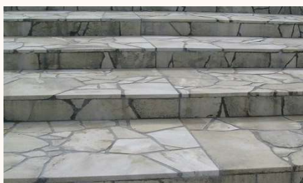
乱張による仕上げ
