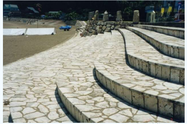
平成8年度施工
