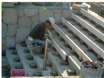
蹴上げの施工(階段工)
