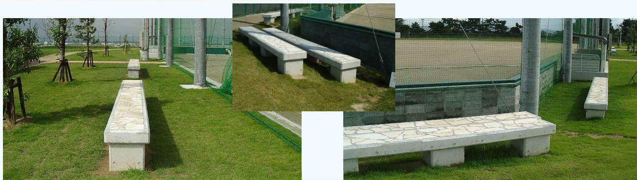
吉富漁港環境整備事業 総合グランド建設工事（福岡県築上郡吉富町）
