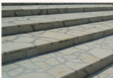
定幅(=蹴上げ高)材料による仕上げ
