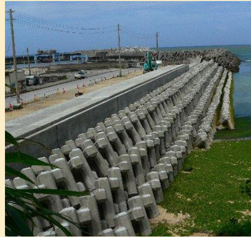
都屋漁港北護岸(三柱ブロック4t型)
