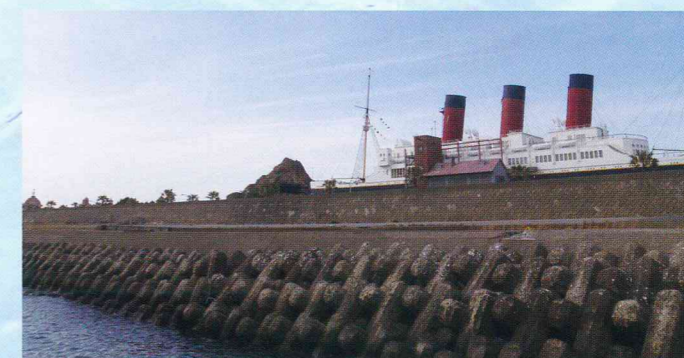
千葉県 東京ディズニーリゾート前面護岸 2t型 1972年施工 2008年撮影
