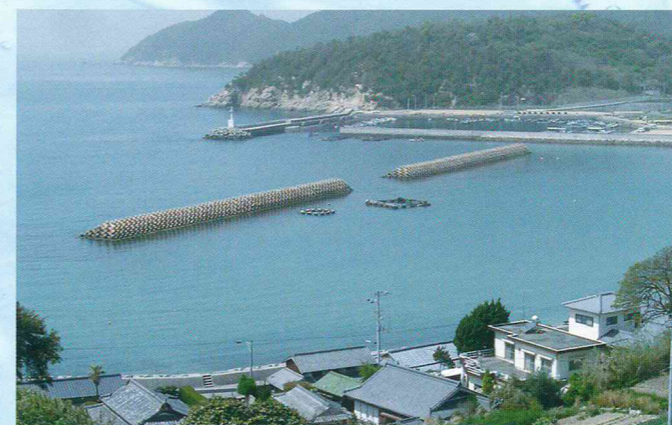
富山県 下新川海岸 16t型3層積 1998年据付 2008年撮影 近隣における主な波浪災害 2008年2月高波災害
