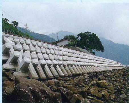
鹿児島県 深港海岸 2t型 1999年施工
