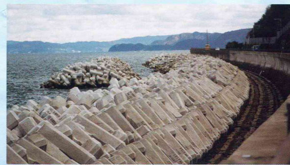
徳島県 国道11号線道路護岸(北灘) 5t型
