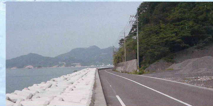
広島県 一般県道上蒲刈島循環線道路護岸 3t型
