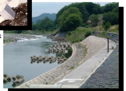
多層組合せ工法
